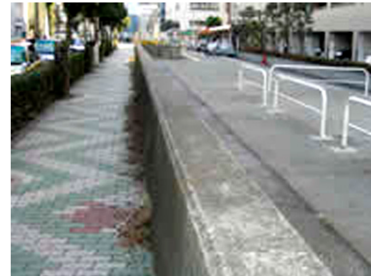
東雲陸上防潮堤
