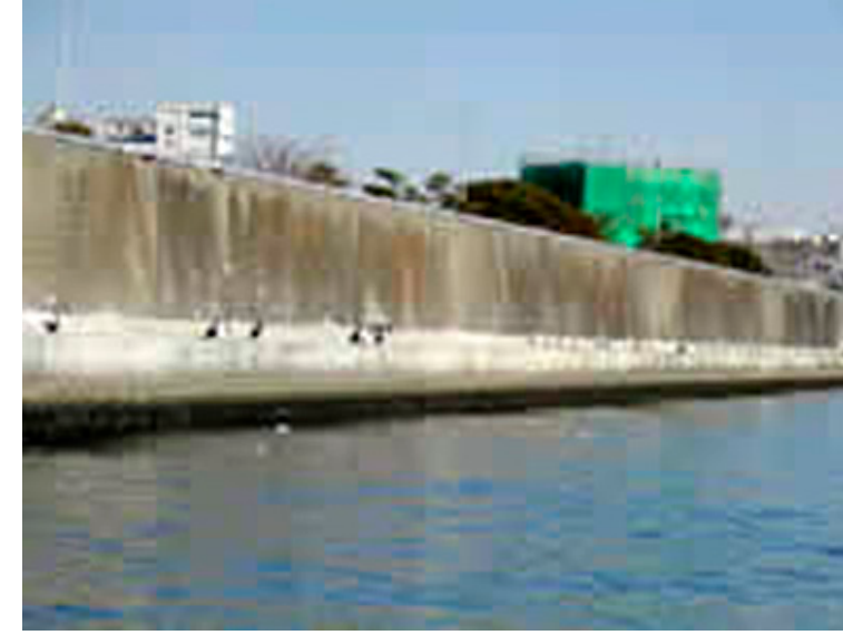
浜離宮防潮堤
